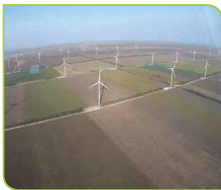
Ботіївська вітрова електростанція
