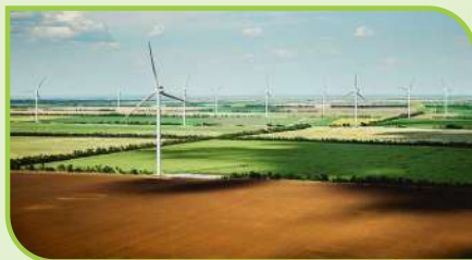
Мал. 122. Ботіївська вітрова електростанція
